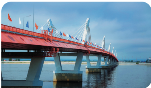
Пограничный мостовой переход через р. Амур
