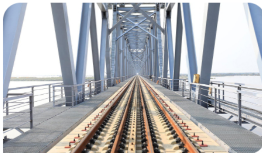
Строительство ж/д моста в районе Джалинда (РФ) – Мохэ (КНР)
